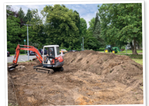
Bagern für den neuen Schuppen hinterm Gemeindehaus
